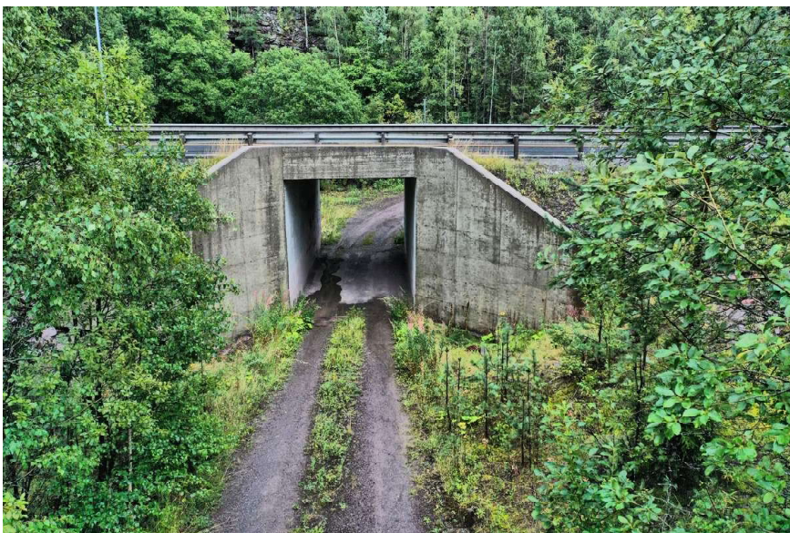
Udrgang fra nordgående kjrefelt ved E16
